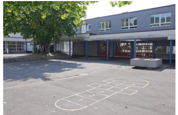
Schulhaus Unterboden, hier befindet sich Ihr Arbeitsplatz!
