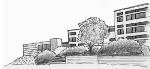
Schule Rümelbach Rümlang
